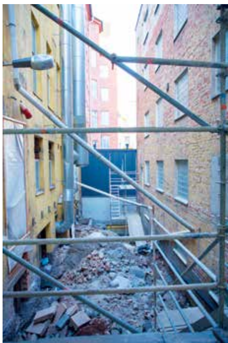
Hotellgästerna behöver inte sucka över utsikten då de tar bron över till Gillegården. De två stora hålen blir dörrar till kökslokaler.
